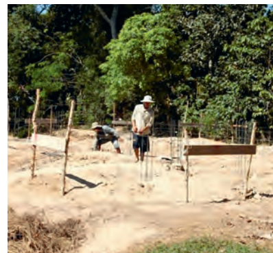
Dernier jour de chantier
