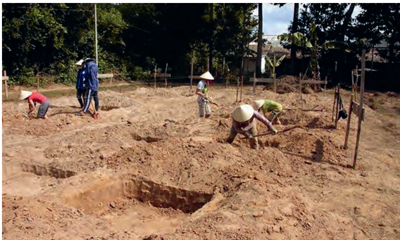
Creuser les trous pour les fondations
